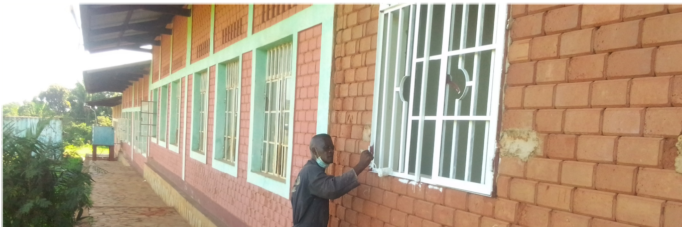
Après les travaux de finition sur les salles qui constituent le « Bloc 4 », Ces locaux sont cours d'utilisation.
