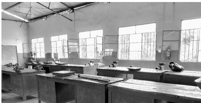
Vue intérieure de l'atelier mécanique, construit et équipé par Enabel.
